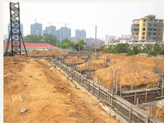
青島泥布灣污水處理廠四期工程建設現場。
