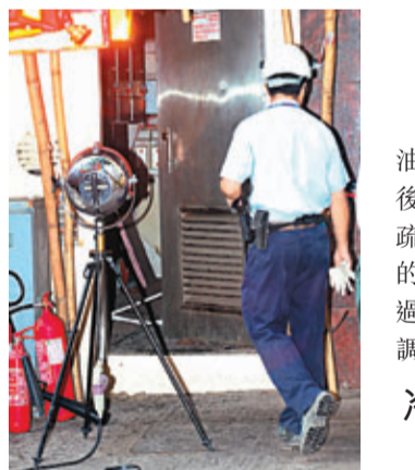
柴灣道金源洋樓發生火警的電錶房。
