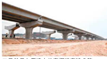
早前仍在興建中的高欄港高速公路。網上圖片
