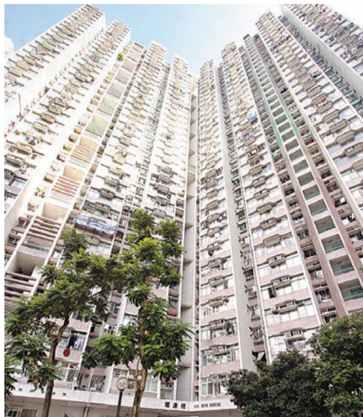
馬鞍山耀安邨耀謙樓高層2室，獲「白居二」以270萬元承接，實用面積呎價6,095元，建築呎價4,753元，創屋苑呎價新高。圖為耀安邨耀謙樓。
