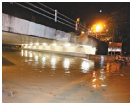
新田公路橋底一條隧道水浸，水浸至近3呎高，行人及車輛不能通過。
