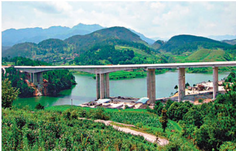
■泛珠9省區將加快廈(廈門)蓉(成都)跨省高速公路的建設。圖為廈蓉高速清江大橋。網上圖片
