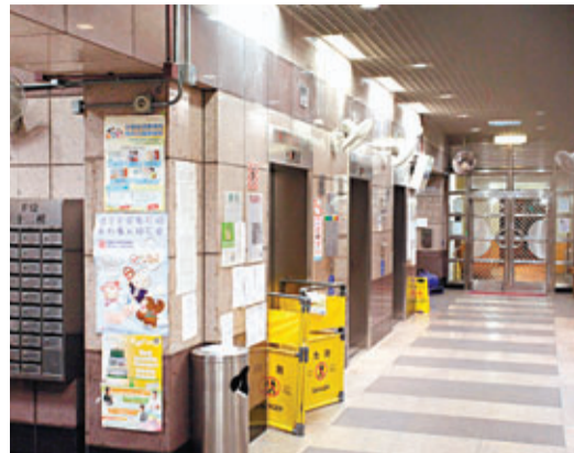
機電署指富韻樓升降機下降速度正常，並無出現急墜的情況。
