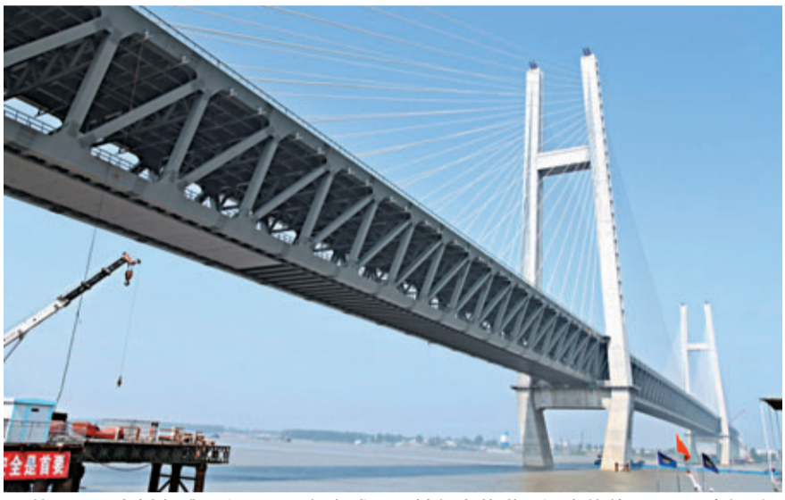
黃岡長江大橋主體工程現已全部完成，預計年底能滿足通車條件。 俞鯤攝
