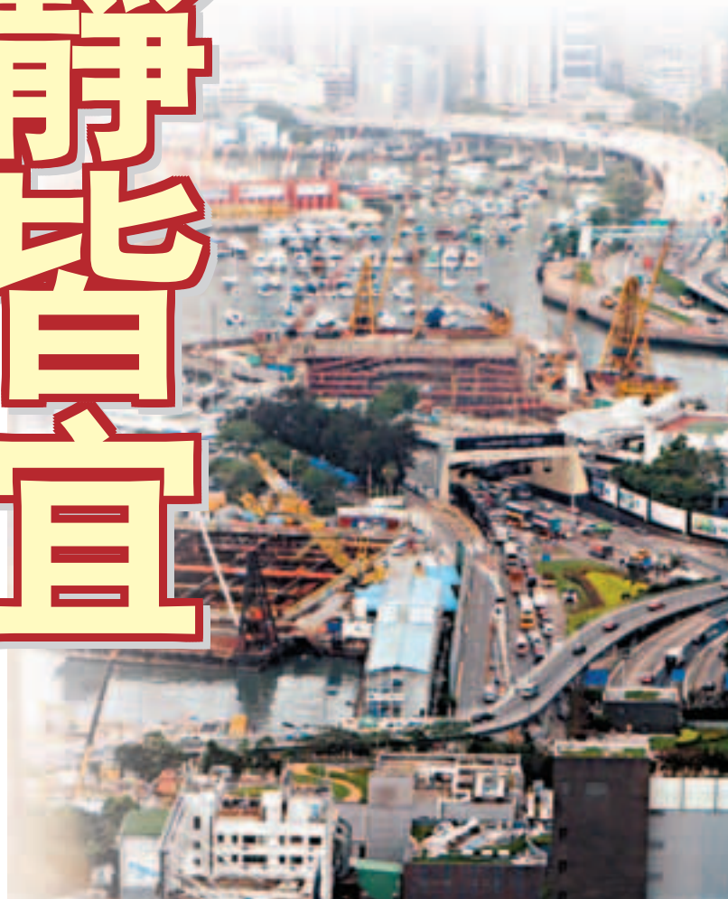
■灣仔海岸線填海多年，正進行中環灣仔繞道工程。
