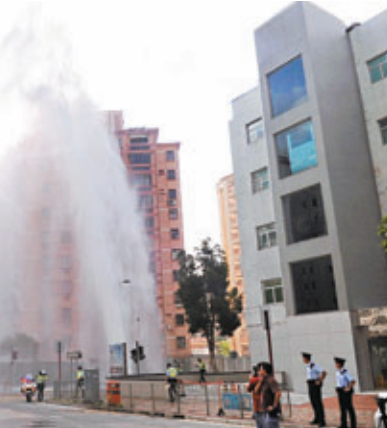
■爆裂水管的水柱直衝半空，蔚為奇觀。
