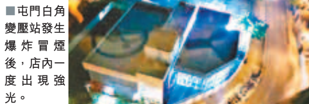
屯門白角變壓站發生爆炸冒煙後,店內一度出現強光。
