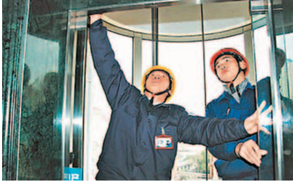
■上海研究引入電梯安全責任保險機制。圖為當地維修人員在檢查電梯。 網上圖片
