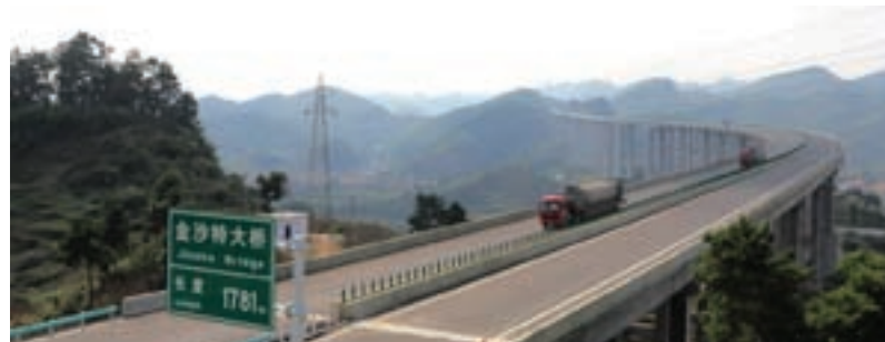
■ 金沙交通便捷，圖為杭瑞高速公路金沙特大桥。
