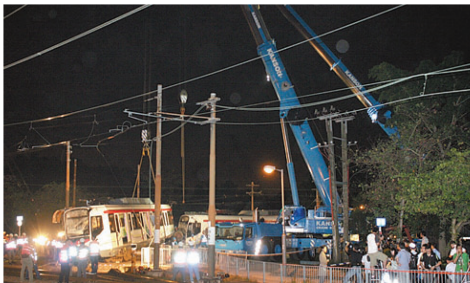
港鐵出動重型吊機通宵吊走肇事輕鐵以進行搶修路軌及架空電纜。
