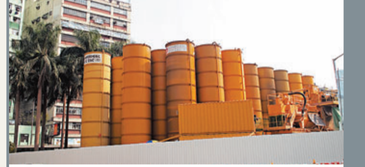
港鐵在工地內使用靜音機械、裝設隔音或吸音設備等，減低工程對附近環境構成滋擾。陳錦燕攝
