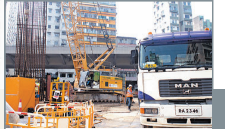
在馬頭圍道一帶的工地，有不少大型機器進駐，噪音難免。陳錦燕攝
