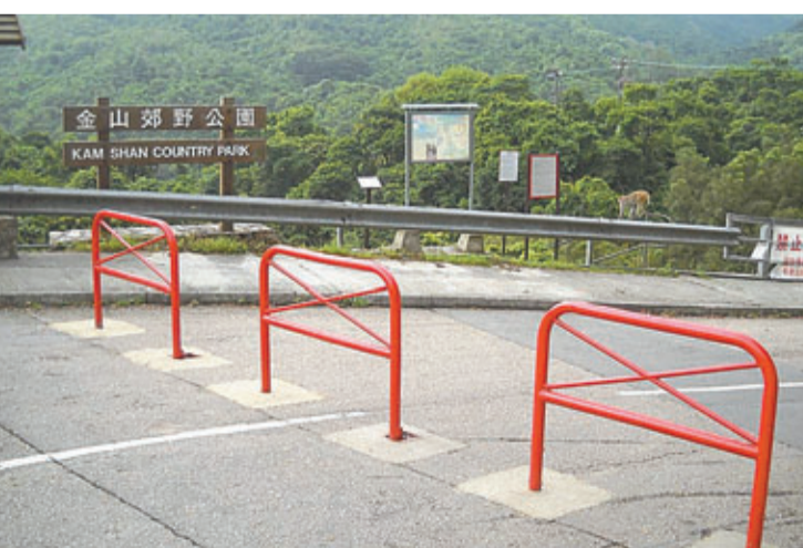
承建商最終在2012年3月才完成有關閘口改建工程。
