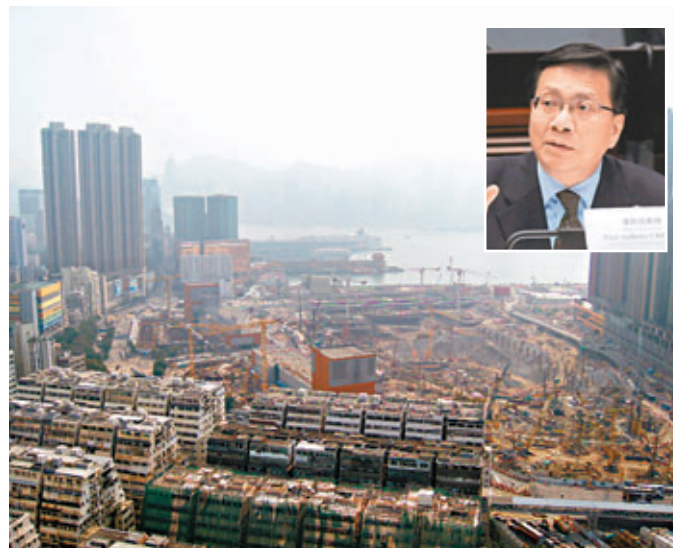
■高鐵西九總站地盤。
