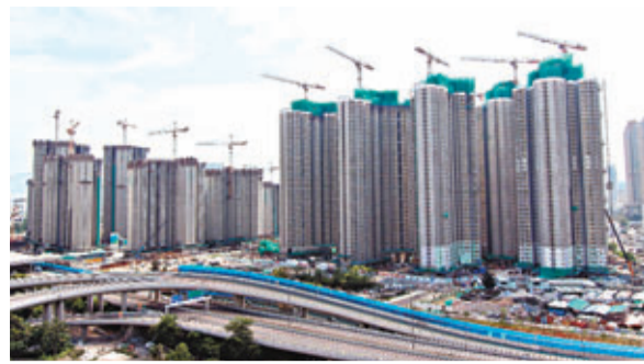
圖為興建中的新樓盤。資料圖片
