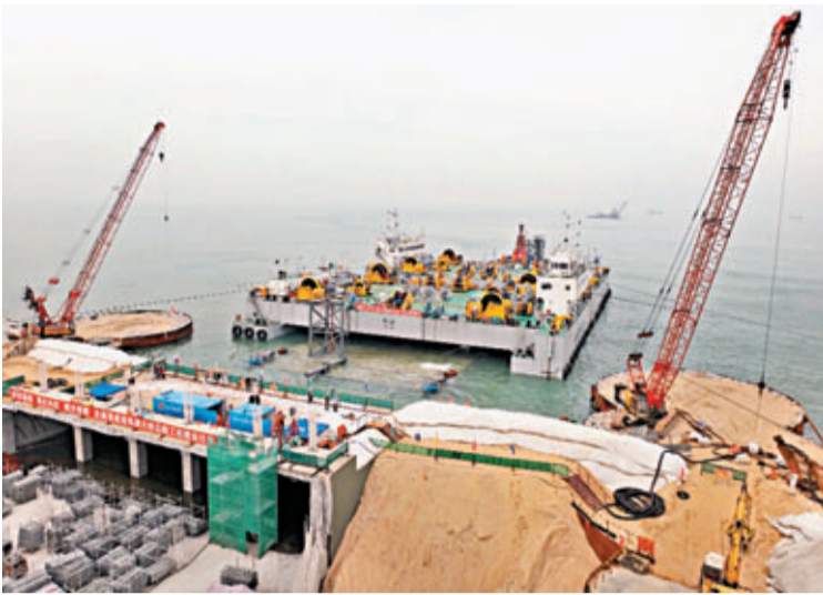
■經過近86小時工序,首節沉管與西人工島現澆築段在海平面下13米深處成功對接。香港文匯報記者張廣珍攝
