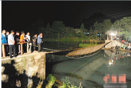
鳳凰吊橋發生傾斜,多人落水。圖為事發現場。
