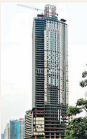
■曾被稱為穗第一大爛尾樓的原合銀廣場現已復工。
