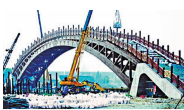
「歡樂胥江」木拱橋進行承載力測試。網上圖片
