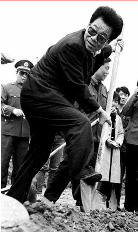
■1986年10月，李瑞環參加天津外環線建設工地勞動。王曉雪 翻拍
