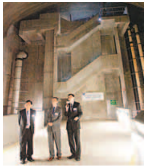
香港工程學會認為，本港首個建於岩洞內的海水配水庫工程，可為香港及亞洲的可持續發展提供成功範例。 莫雲芝 攝
