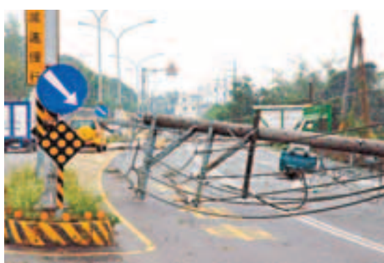
高雄大樹區遭怪風肆虐，滿目瘡痍。 中央社
