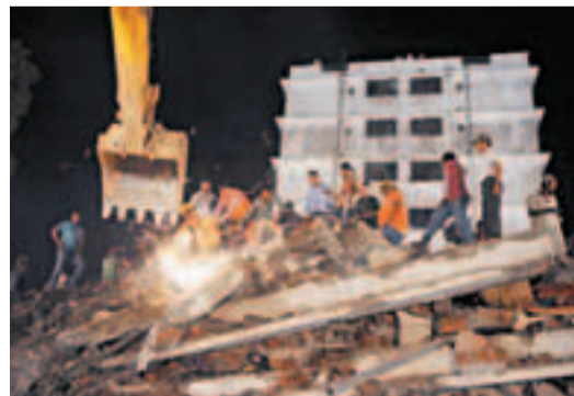
■工人企圖切斷鋼筋，搜救瓦礫下的生還者。法新社
