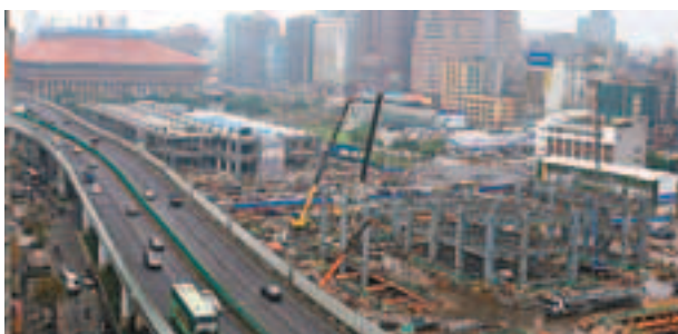
台北車站特定區正在施工的「雙子星大樓」地盤。中央社
