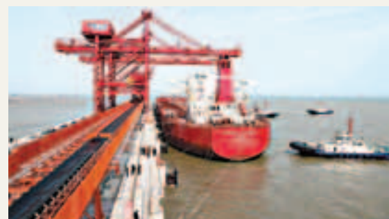
中國建成的第一個30萬噸級(結構兼顧40萬噸)礦石接卸碼頭。 青島港供圖
