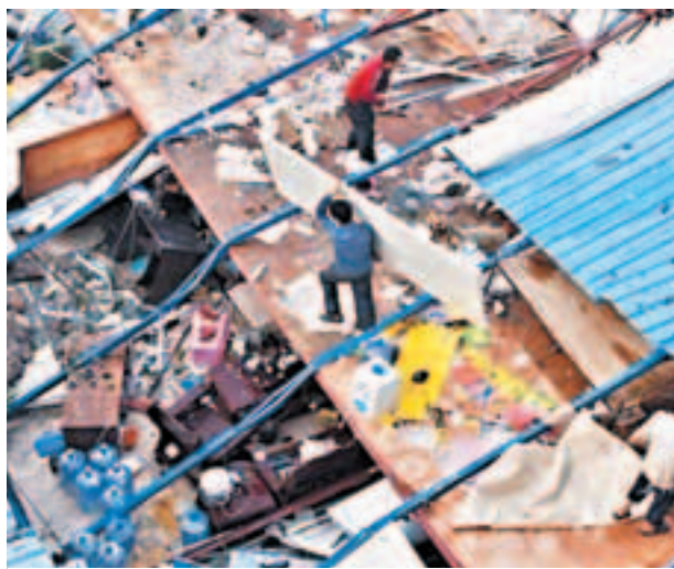
被風颯倒的臨時搭建廠房。本報東莞傳真
