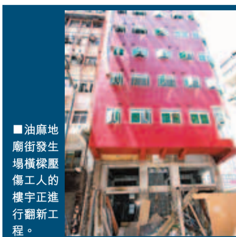
油麻地廟街發生塌樓壓傷工人的樓宇正進行翻新工程。
