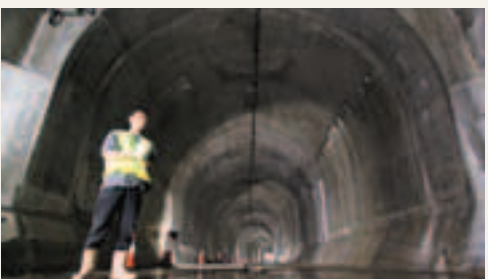
■渠務署會在4月前陸續打開隧道內34個水閘，排放所收集的雨水。
