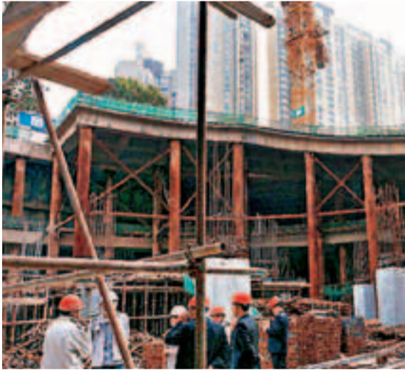
平安金融大廈施工現場已停工。網上圖片
