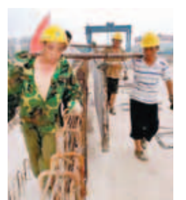
工人早前在南寧至欽州高鐵路面上施工。網上圖片
