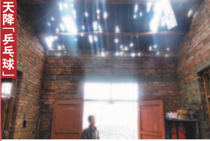
■深圳龍崗一棟住宅疑為鹹水樓，該戶客廳天花板出現裂痕，漏水情況嚴重。
