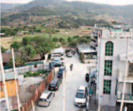
■菜園村因路權問題，菜園村工程車無法進入致拖延重建工程。 資料圖片
