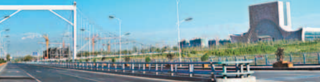
■橫跨在開發區(頭屯河區)小綠谷上的北一路大橋
