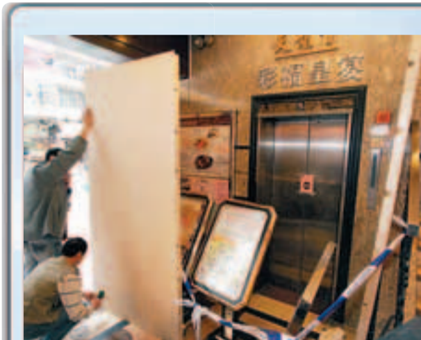
工人用木板將肇事的升降機圍封。資料圖片
