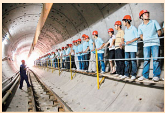
考察鄭州地鐵施工現場
