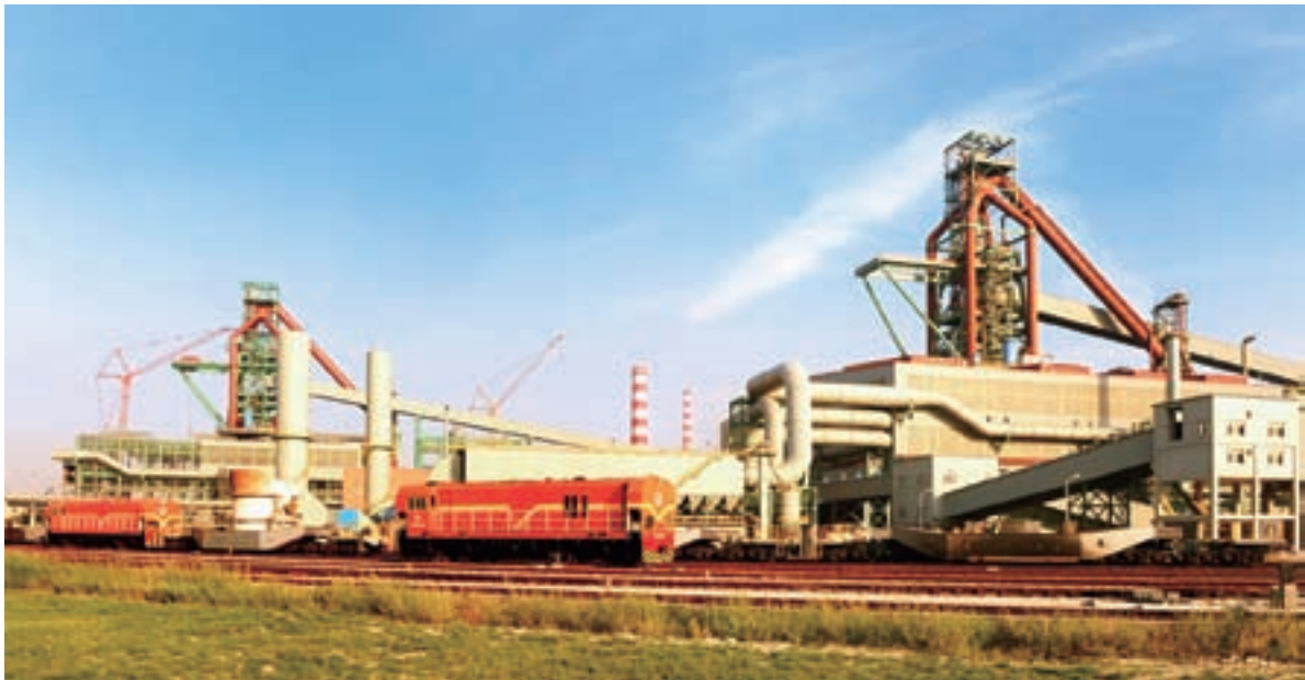
■ 首鋼國際工程公司自主設計的中國第一座5,500立方米特大型高爐
