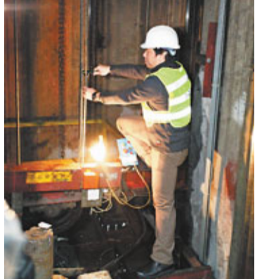
機電工程署人員在觀塘工業中心巡查信科保養的升降機鋼纜。
