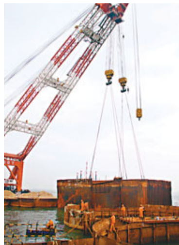
沉管對接前的最後一道工序鋼筒筒切割拆除工作已完成。
