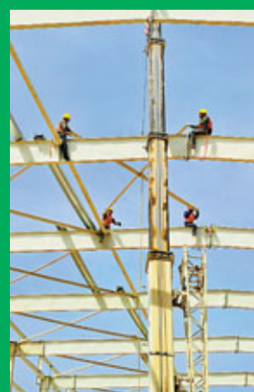
■熱火朝天的蘭州新區建設場景
