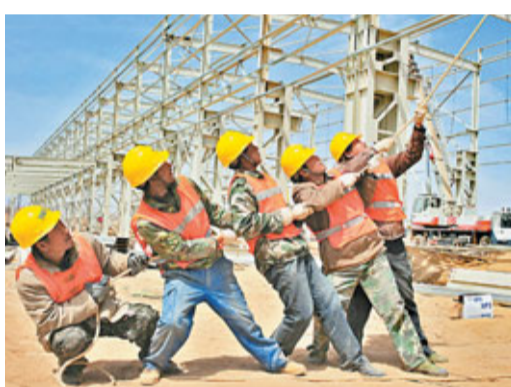
■熱火朝天的蘭州新區建設場景
