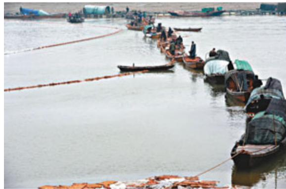
漏油事件導致鄱陽湖畔吳城鎮段水域輕度污染。昨日，漁民正在鋪設用稻草做成的攔油壩。新華社
