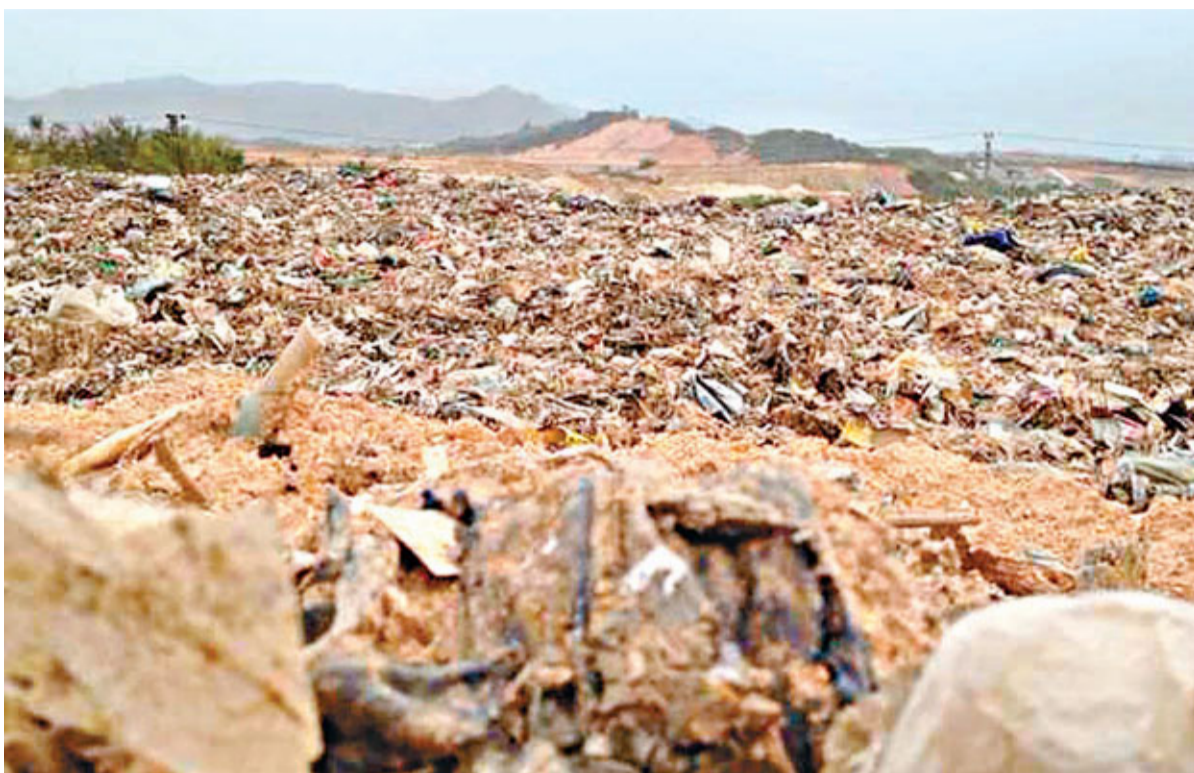
水庫壩邊土壤裡面混雜大量垃圾。
