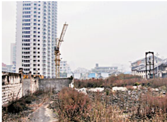
■爛尾盤「泰宇花苑」遍地雜草，起吊機銹跡斑斑。
