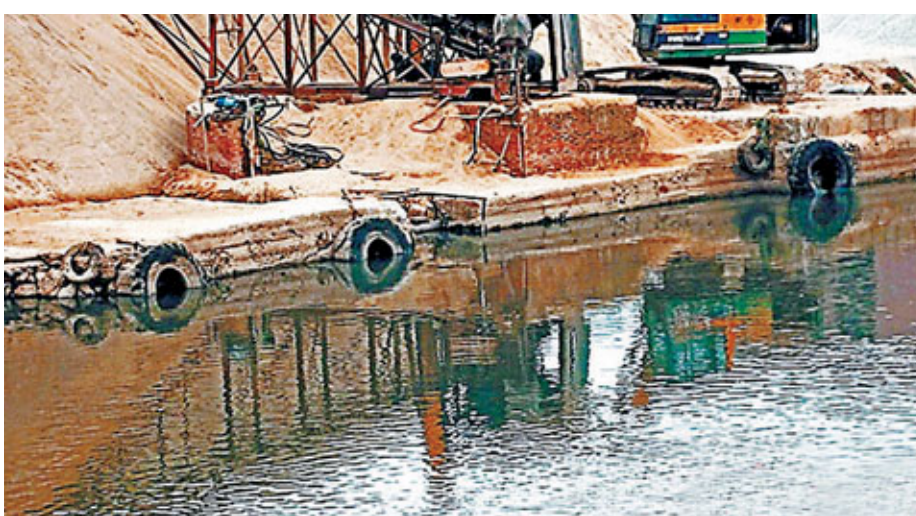
寒溪河角社大橋河段,成排的排污口張着烏黑大嘴。
