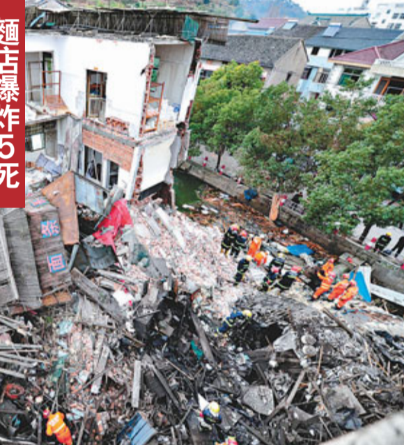
位於浙江寧波施山社區的雅群麵店，3日早晨發生一起疑似鍋爐爆炸事故，事故目前已造成5人死亡，6人受傷，3間3層樓房部分倒塌。圖為救援人員在事故現場。中新社
