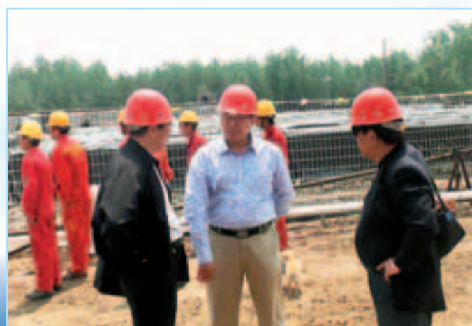
■英發公司技術顧問劉少斌與中聯煤公司郭總一行實地檢查項目施工情況
