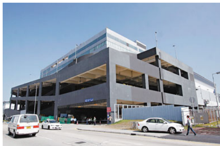
■赤鱘角駿坪路發生跟車工人被貨車尾板夾死的空運中心。
