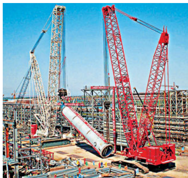
■ 中科煉化項目是內地投資最大的單體項目，前期工程工作量已完成近70%。網上圖片
